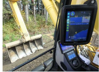
ICT建設機械による施工状況
